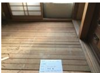
改修前: 既存床(畳)の撤去
