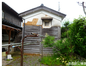
改修前・東面
