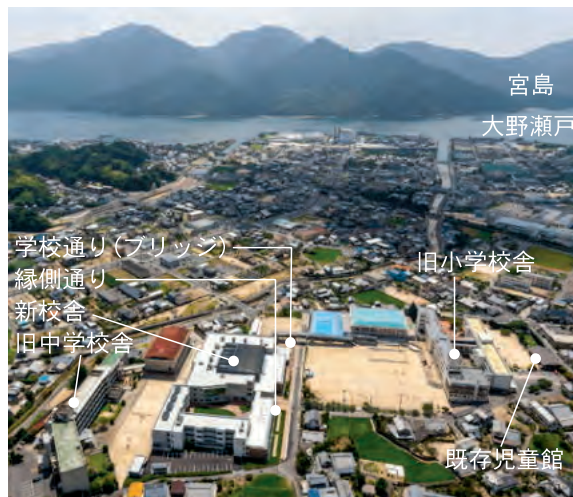
隣接二敷地における居ながら工事を実施
