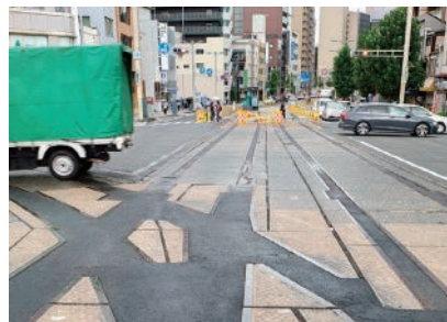
（写真3）的場町軌道撤去
