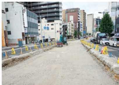
（写真2）的場町掘削
