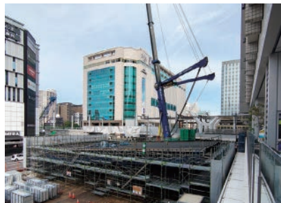
（写真14） 組立中の大屋根
