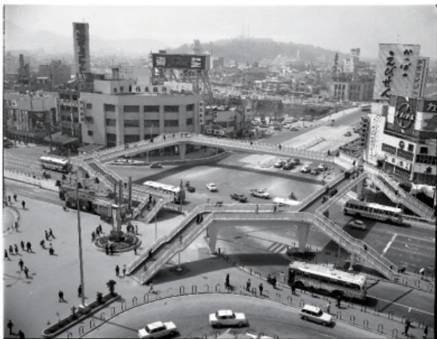
広島駅前のマンモス陸橋。昭和 62 年に撤去された (昭和 43 年撮影 広島市公文書館所蔵)
