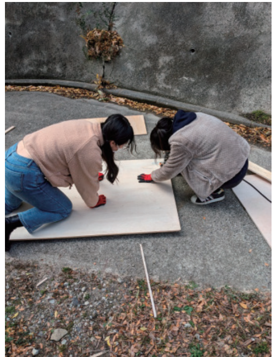
作業の様子 内壁に貼る板を切断中
