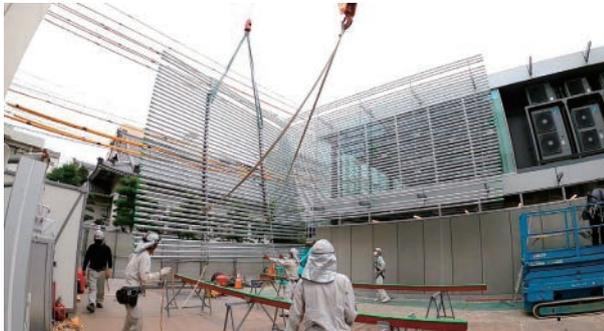
図16：現場でのスクリーン取り付け
