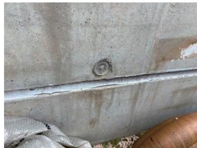
↑シーリングの劣化によるゴムの破断
