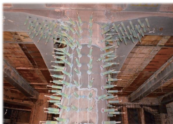
写真7 : 被爆建物・注入状況
