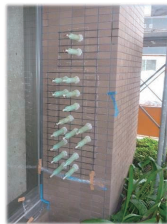
写真3：タイル注入状況
