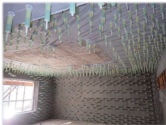
写真2：LOG 注入状況
