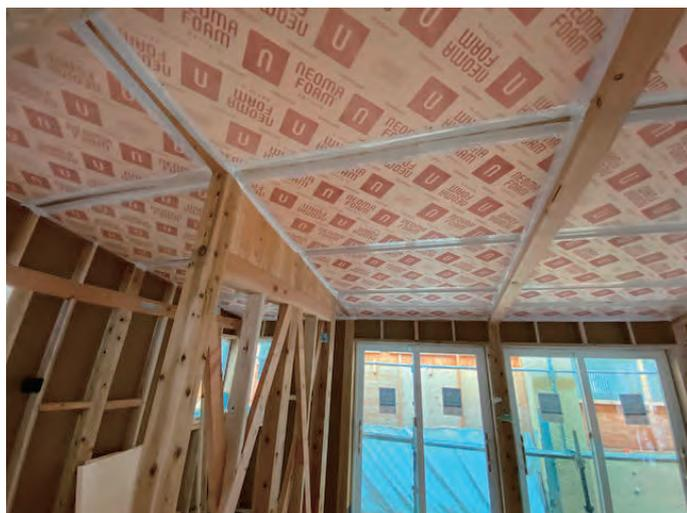
高性能断熱材で屋根からの日射侵入を防ぐ
