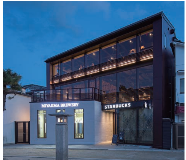
海岸側の全景
