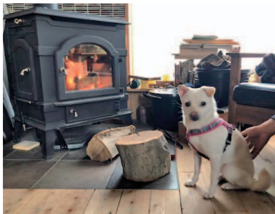
玄関土間の薪ストーブ
