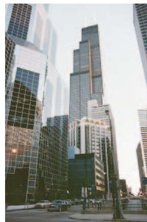
シアーズタワー（現 ウィリス・タワー） （シカゴ・1985）
