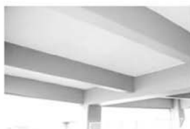
不燃断熱材 セラミライトエコG
