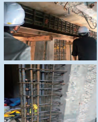
【耐震リフォーム工事の施工事例写真（梁・壁部分）】
