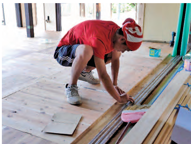
床板張りと微調整
