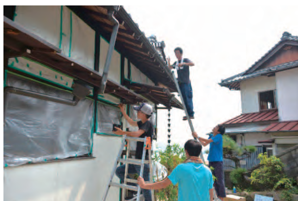
外部木部のベンガラ塗り
