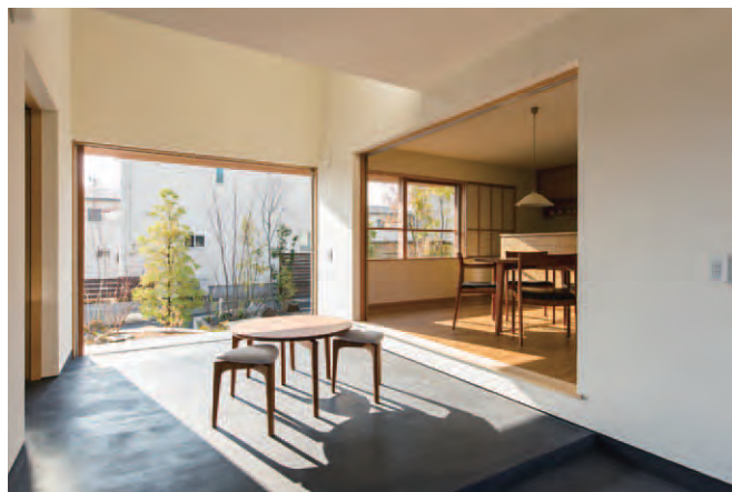
通り土間から南庭を見る。冬の日射熱を床に蓄熱させる。
