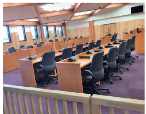
議場は火災の時の燃え代を考慮して 大きな木柱となっている。
