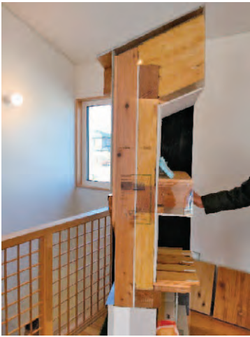
エコハウスの建物断面模型 屋根厚300・外壁厚200の 断熱材入り
