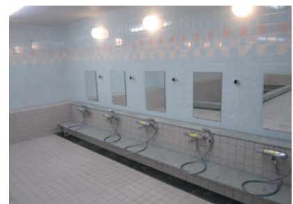
管理棟 共同浴室
