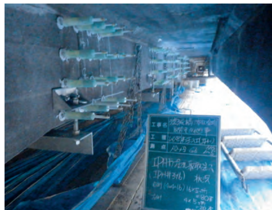
橋桁 注入状況
