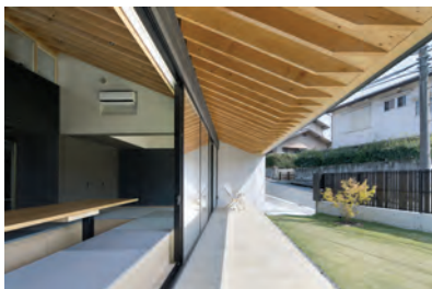
テラス1（西から東方向）
