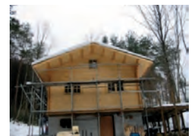
窓の取り付け
