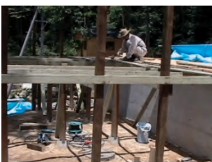
テラスの設置
