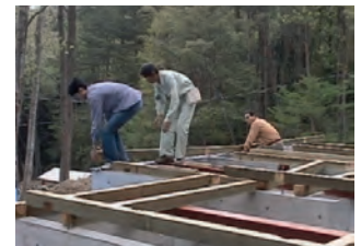
土台の取り付け
