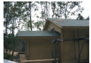
薄暗くなっても頑張る屋根工事
