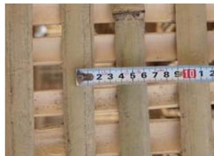
土塗壁は、小舞を下地とした荒壁の表裏が一体となることで、強度が発揮できます。そのため、小舞竹の間隔は強度にも大きく影響してきます。
