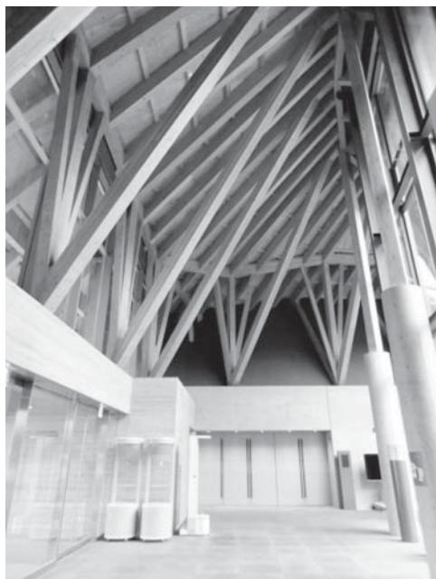
正面エントランス付近の屋根架構
