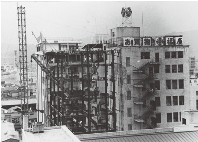
鉄骨建方で自家製のアームデッキ
