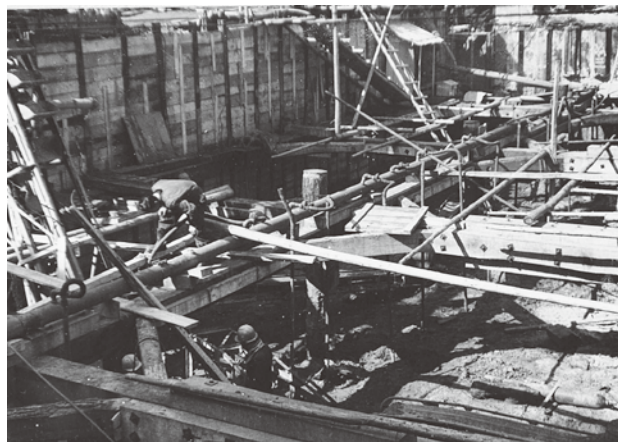
排水工事（ウエルポイレツス工法）
