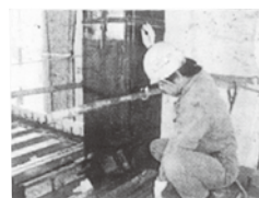
超音波探傷検査状況
